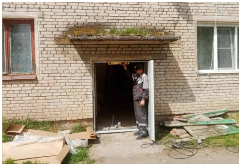
Фонд, доставшийся УК «Жилищник», — старый, зачастую в домах выбиты окна, нет дверей, сгнили печные трубы, регулярно возникают протечки воды. На снимке: установка новой двери на подъезд многоквартирного дома в деревне Трубиchino Новгородского района.
